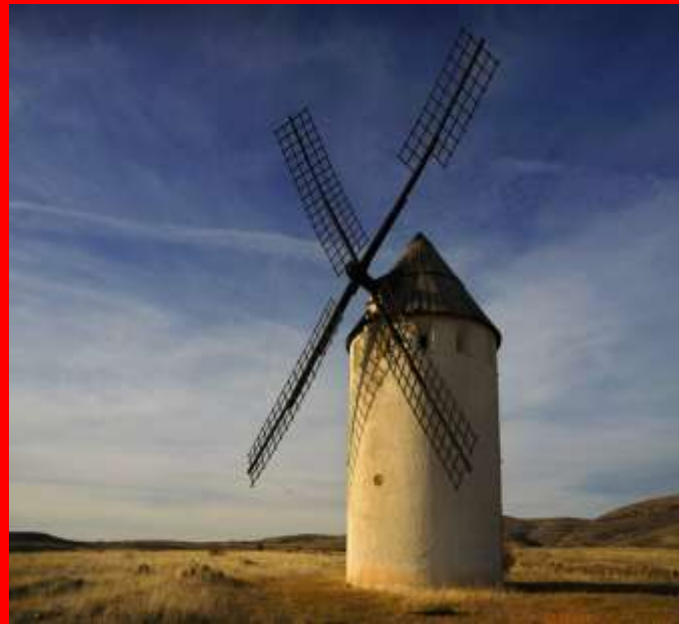
Antiguo Molino de Viento, los monstruos de Don Quijote de la Mancha
